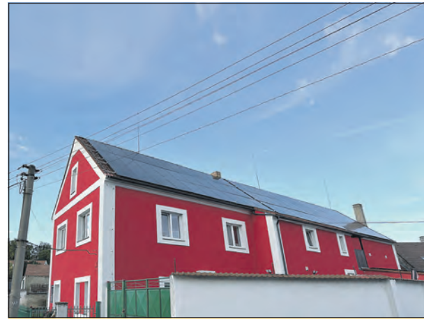
Fotovoltaická elektrárna na střeše domu v Řisutech (řeznictví U Chvapilů).
