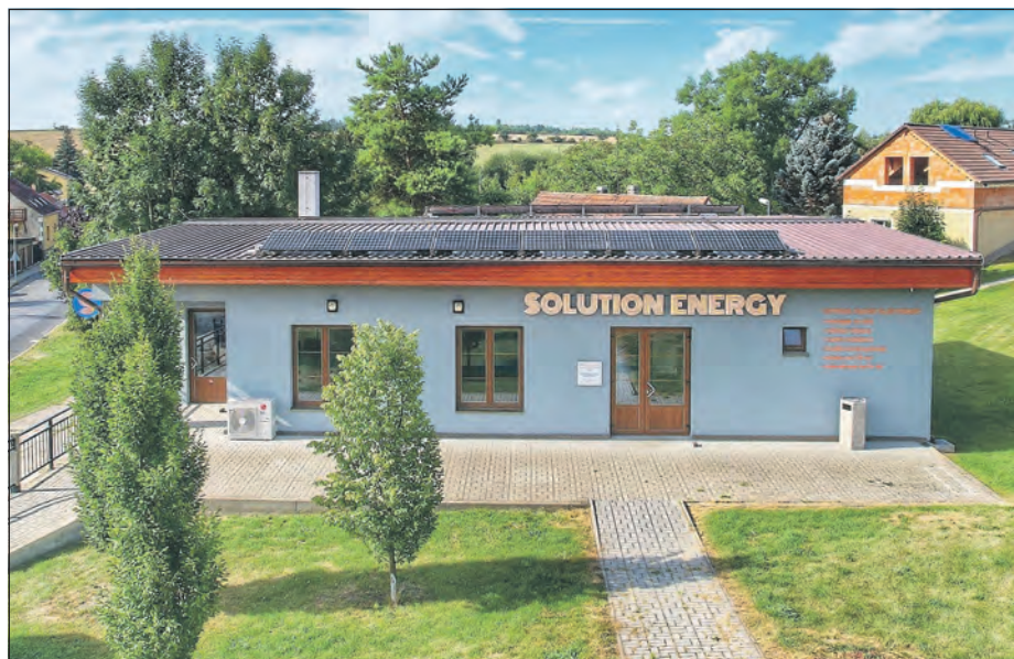
Sídlo společnosti SOLUTION ENERGY ve Studeněvsi u Slaného.
