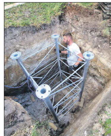
Josef Trembecký při kontrole umístění základu nového stožáru kousek od Slaného.
