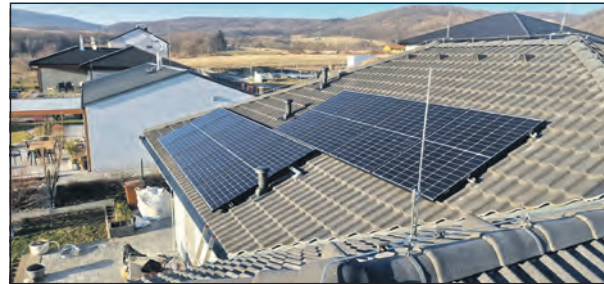
Dům v Ústí nad Labem, na jehož střechu firma Solution Energy v nedávné době instalovala solární panely.
