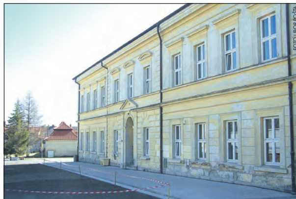
Před starou budovou základní školy byla položena nová zámková dlažba.
