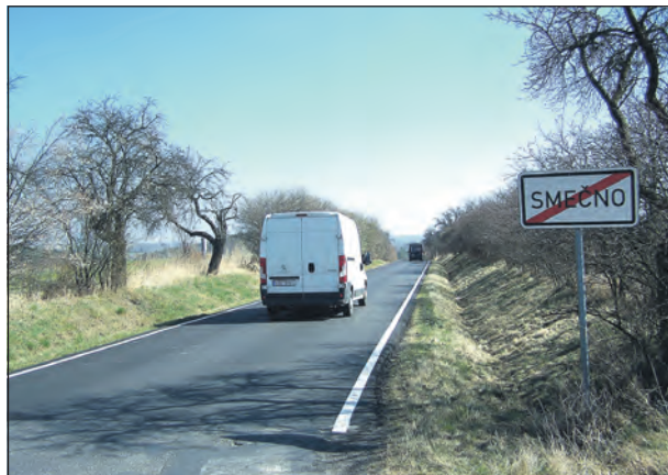
Na silnici ze Smečna do Třebichovic byl položen nový asfaltový povrch.
