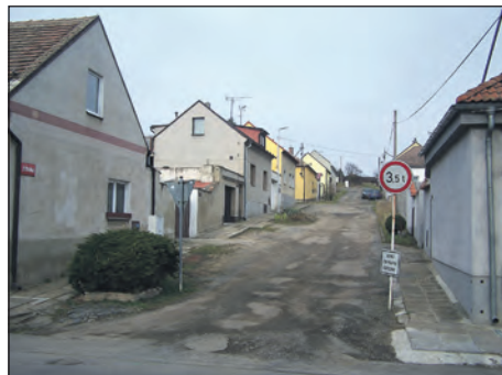
Takto to dnes vypadá v Žižkově ulici ve Zlonicích. Kdy začne její rekonstrukce?
