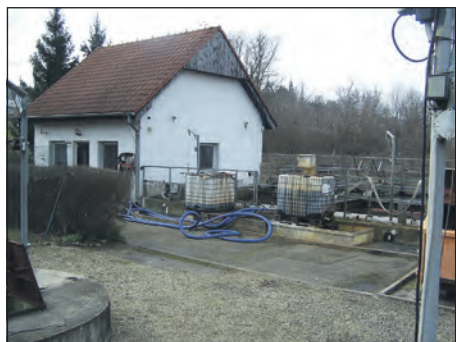
Stávající ČOV ve Zlonicích je dnes na hraně své kapacity.
