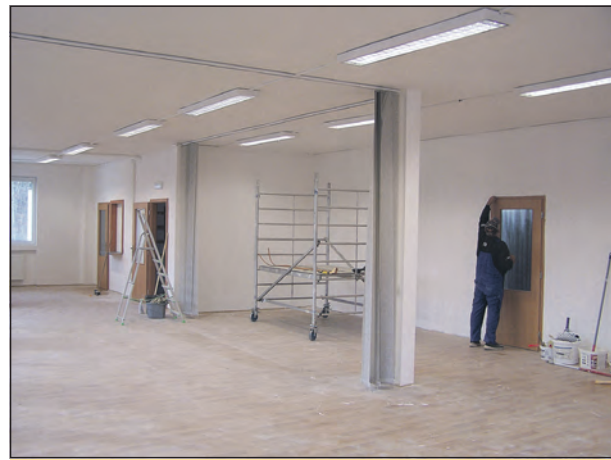
Interiér budoucí školky v Pippichově ulici se již dokončuje.
