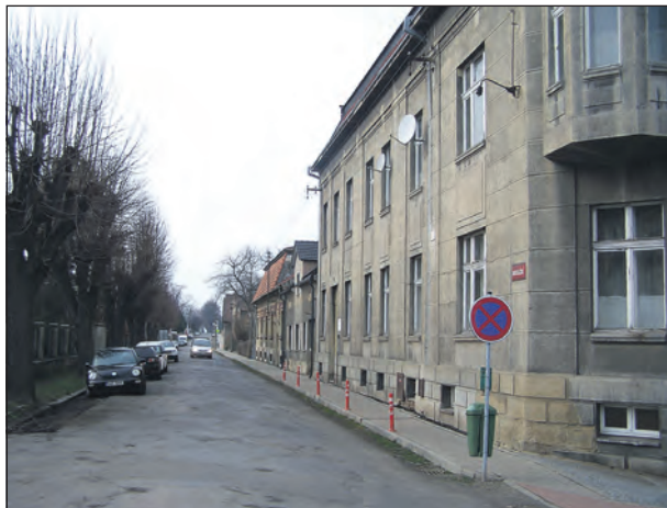
Tato část Nádražní ulice ve Zlonicích bude kompletně rekonstruována.
