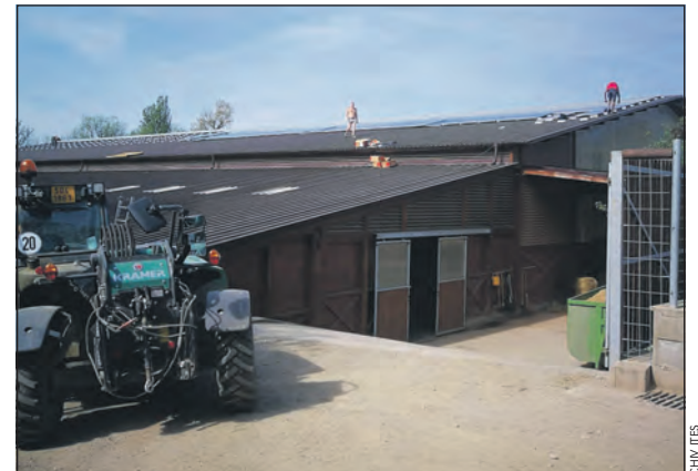
Realizace pokládky panelů na střeše jezdecké haly.
