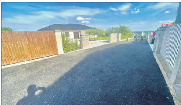
Takto vypadá nový povrch v ulici Padlých Hrdinů, zhotovený z asfaltových recyklátů.
