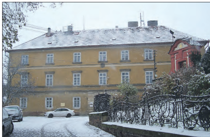
V zámecké budově se rekonstruuji uvolněné byty.
