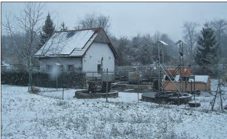
Rekonstrukce zlonické ČOV bude náročná nejen z pohledu nemalých nákladů na tuto investiční akci.
