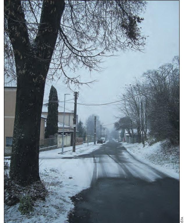
Nádražní ulice bude zrenovována od aleje u vlakového nádraží až k budově zdravotního střediska.
