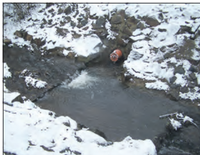
Dnes je technologie čištění v místní ČOV již vyladěná a z odtokové vpusti vytéká krásně čistá voda.
