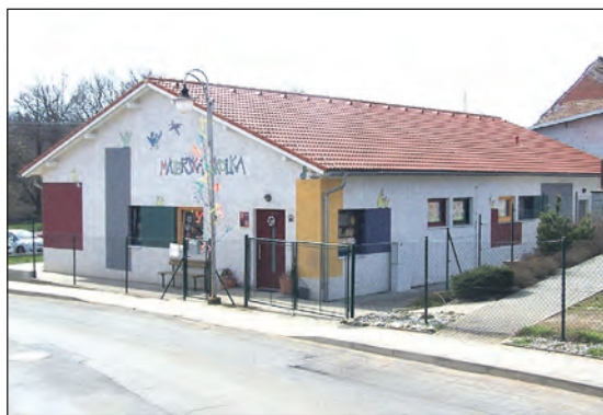
Fotovoltaická elektrárna bude v Královicích instalována i na střechu mateřské školky.
