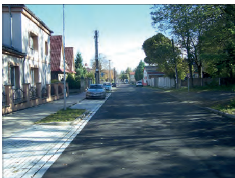
Jednou z největších investičních akcí v tomto volebním období byla rekonstrukce velké části Nádražní ulice.
